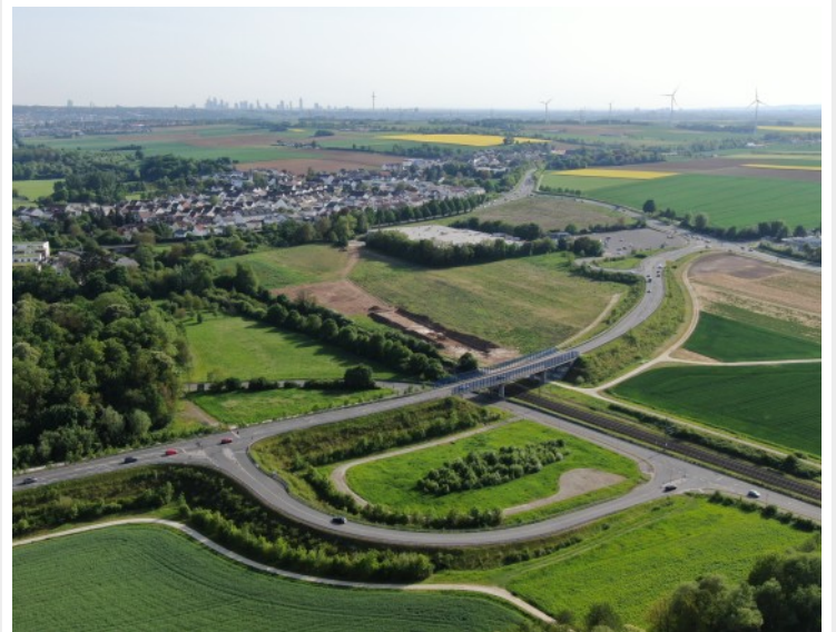
Die Nordumgehung hat Karben enorm vom Verkehr entlastet.
